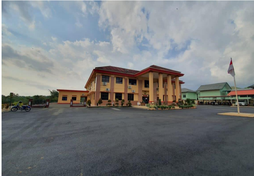
Gambar 4.1 Gedung Pengadilan Negeri Tais
