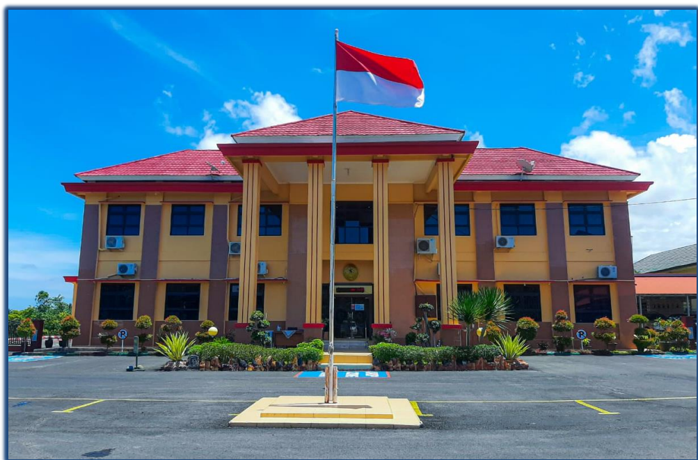
Gambar 4.1 Gedung Pengadilan Negeri Tais
