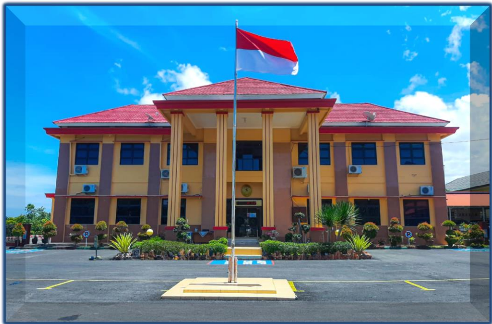
Gambar 4.1 Gedung Pengadilan Negeri Tais
